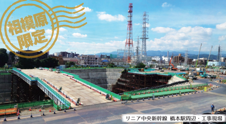
リニア中央新幹線 橋本駅周辺・工事現場
